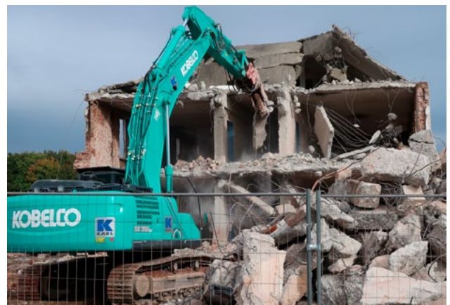
München: Nach dem Abbruch soll möglichst viel Material wiederverwendet werden.
