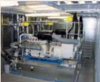
Kraft-Wärme-Kopplungsanlage im Stadttheater: 2 BHKW Module mit je 350 kW elektrischer / 520 kWh thermischer Leistung
