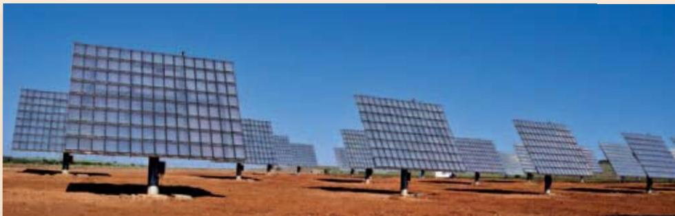
500-kW-CPV-Kraftwerkseinheit in Puertollano, Spanien. Foto: Concentrix Solar.
