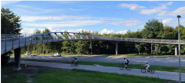
Fahrradbrücke auf dem Radschnellweg | Foto: Stadt Böblingen
